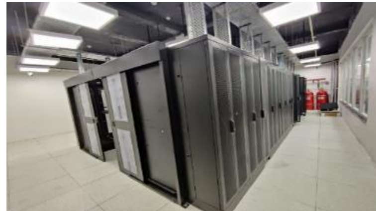
Actual site pictures : OT DC
