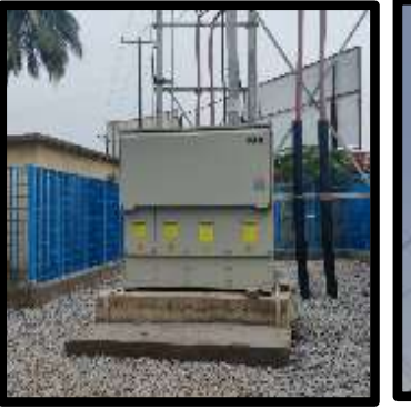
HT Protection: RMU - 11 Nos. & ARSR – 20 Nos
